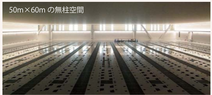
計算機棟3階の計算機室（864台のシステムラックが並んでいます）
